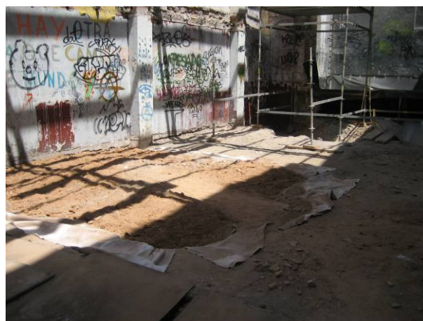
FOTO 16. Estat final després de la intervenció
