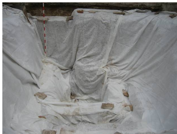
FOTO 14. Cobriment de les restes i dels talls del sondeig amb geotèxtil
